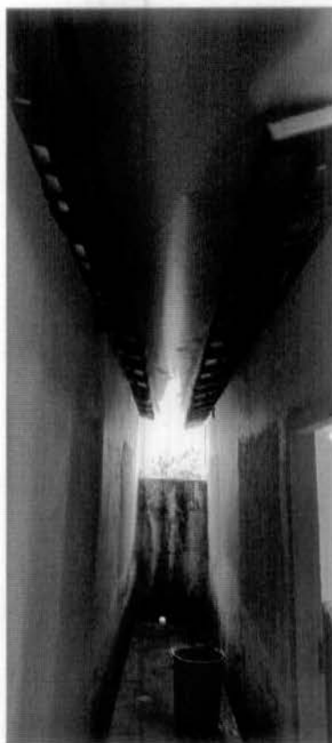
Imagem 06 – Troca de calha de zinco na cobertura
