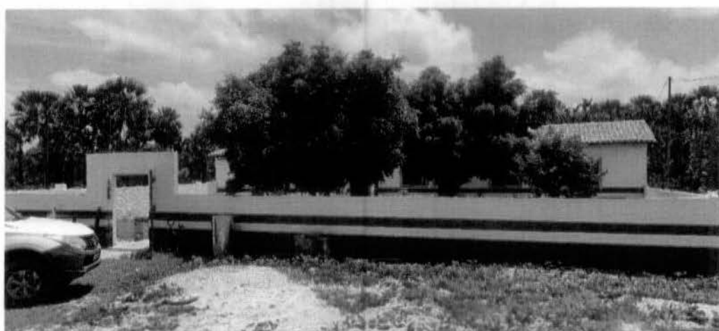
Imagem 08 – Pintura do Muro (externo)
