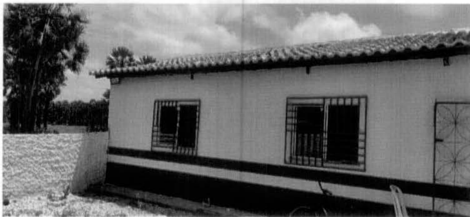
Imagem 02 – Instalação de esquadrias de vidro e grades de proteção
