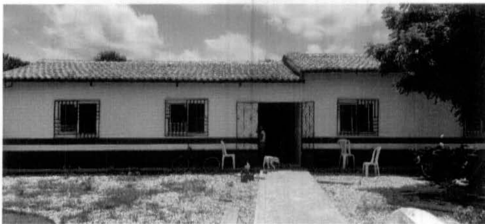
Imagem 01 – Aplicação de selador e pintura com textura, padrão PMC na fachada principal da escola
