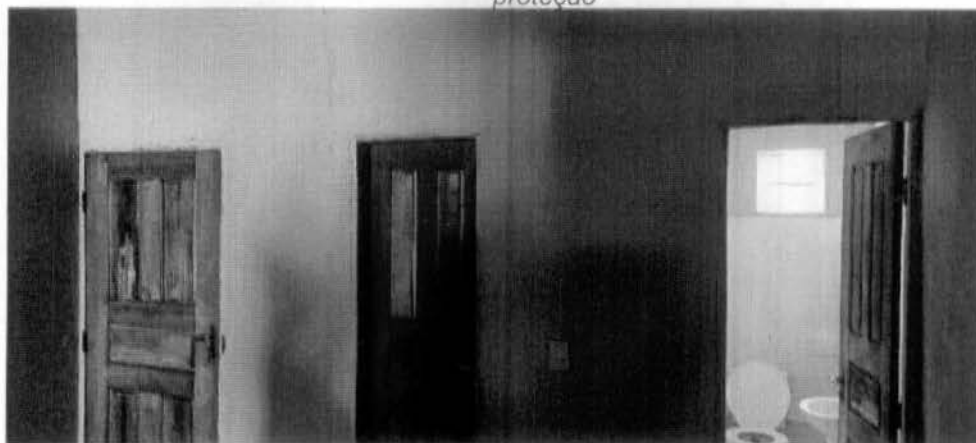
Imagem 03 – Troca de portas de madeira nos banheiros
