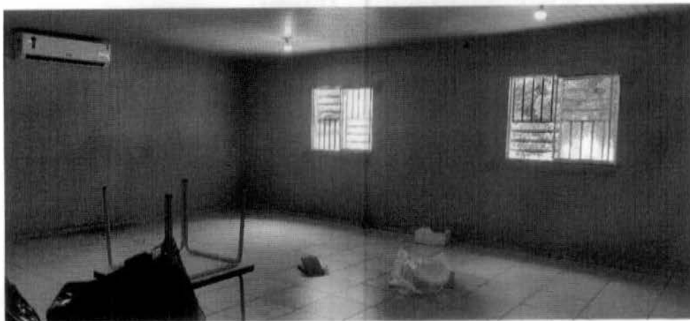
Imagem 04 – Pintura interna nas salas de aula
