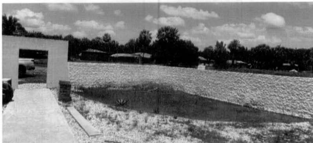
Imagem 07 – Pintura do Muro (interno)
